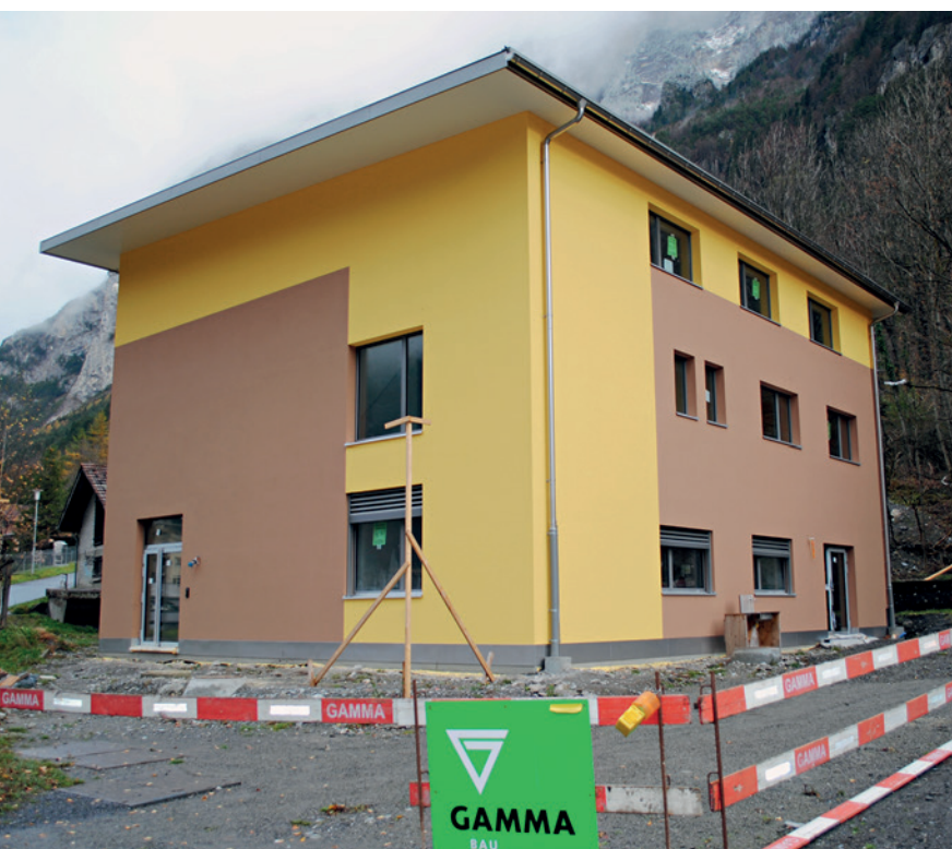
Baustelle des ersten Urner Pfadiheims in Erstfeld
