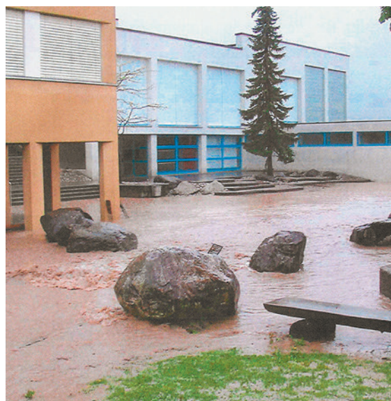
Hochwasser 2002 – Schulhaus Gräwimatt
